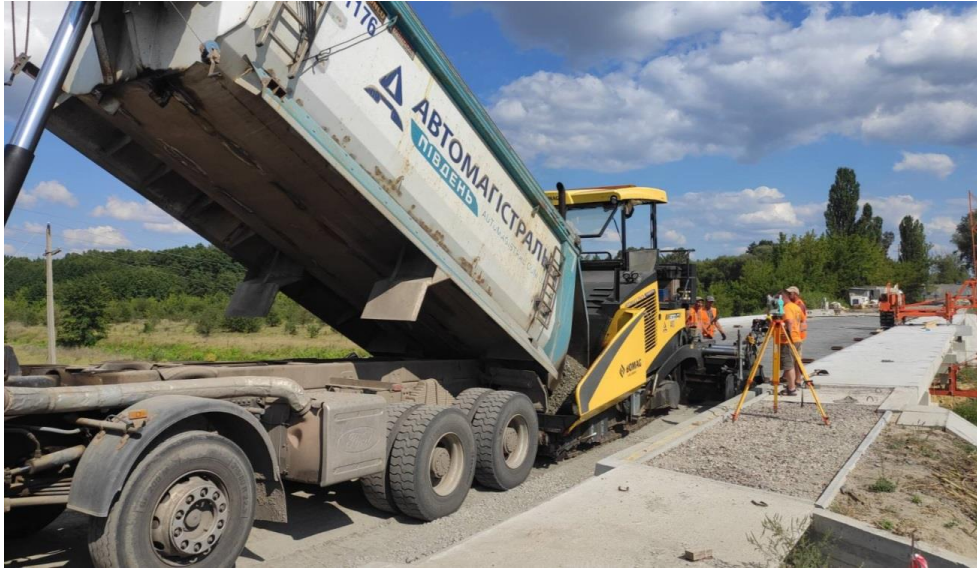
Рисунок 3 — Укладання укріплених цементом щебенево-піщаних сумішей
