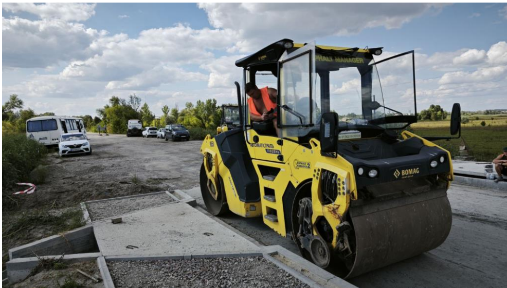
Рисунок 4 — Ущільнення укріплених цементом щебенево-піщаних сумішей
